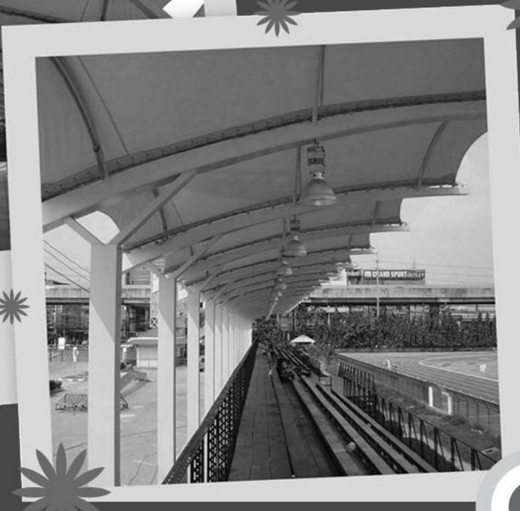
กลับมาพบกันอีกครั้งในคอลัมน์ Site Hits เดือนนี้ขอแนะนำคุณไปชมผลงานผ้าใบอัจฉริยะกีฬา ซึ่งใช้ผ้าใบ Fabric Tentioned Membrane SCC 125 NanoTio2 Fabric ในการก่อสร้าง อัฒจันทร์นี้ ได้ก่อสร้างไว้ภายในบริเวณสนามกีฬาห้วยหมาก อีกทั้งงานนี้ไม่ต้องห่วงเรื่องความแข็งแรง คงทน ถ้าใครว่าผ้าใบไม่แข็งแรงคงต้องไปพิสูจน์กันด้วยตาของคุณแล้วละครับ พบกันฉบับหน้า !!! ▶
